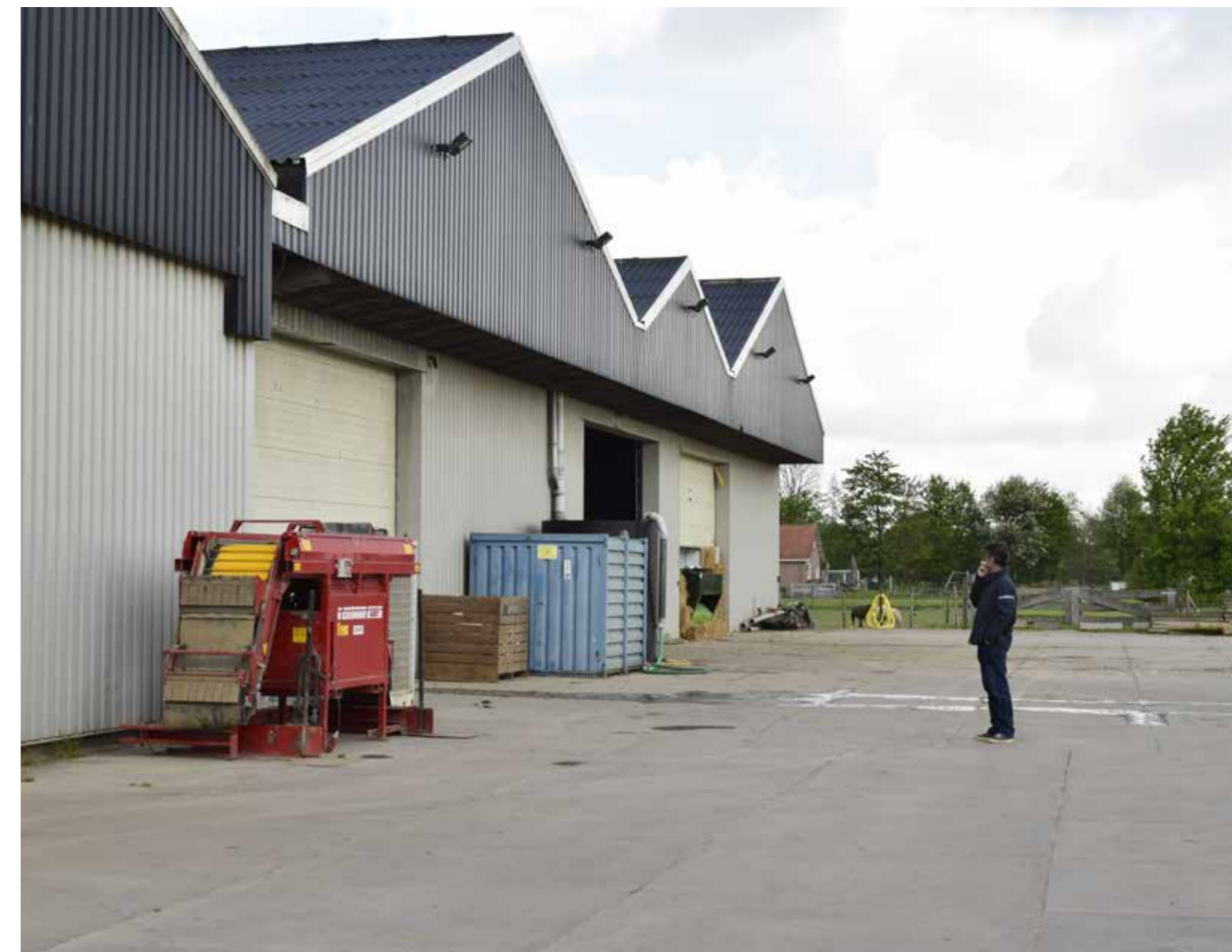
Vooran de koelcel waar het indirecte koelsysteem wordt toegepast en rechts de cel die is uitgerust met de QCC.
